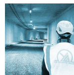
Tunnel Baukau - Herne
